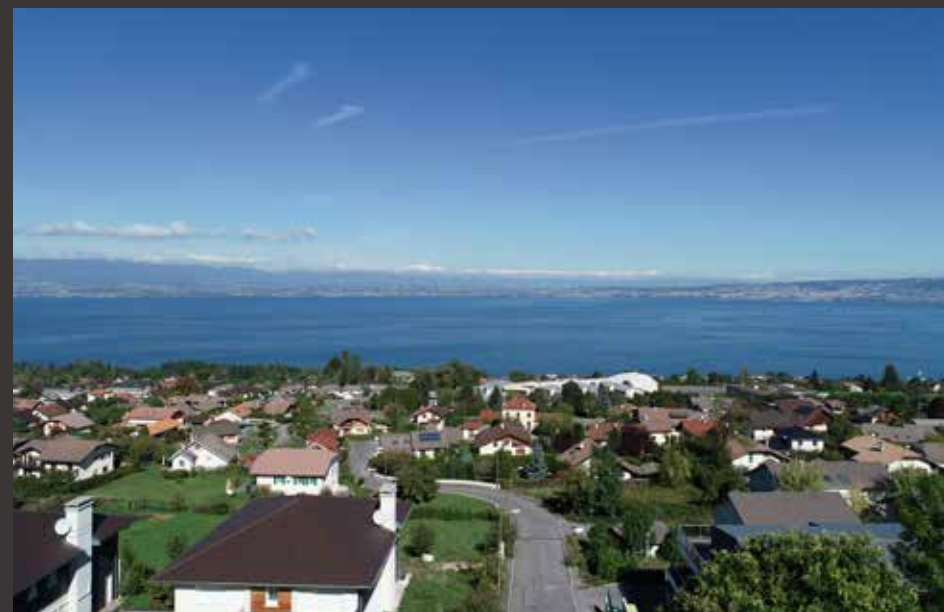
• Vue de drone depuis le dernier étage du bâtiment B.
